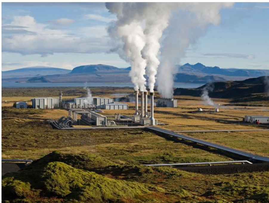
Σχήμα 1.10: Εγκατάσταση εκμετάλλευσης γεωθερμικής ενέργειας
