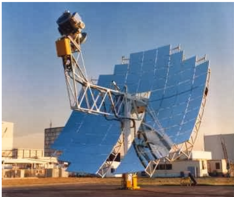
Σχήμα 2.3: Ηλιοθερμικό παραβολικό πιάτο με κάτοπτρα
