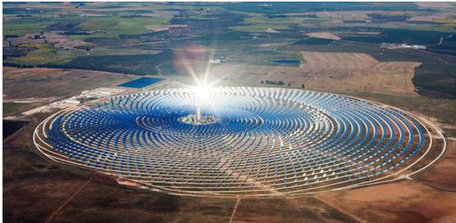
Σχήμα 2.2: Ηλιακός πύργος 260 MW στη Χιλή
