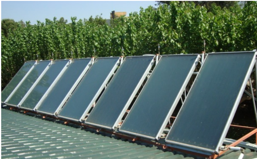
Σχήμα 1.2: Ηλιοθερμικό σύστημα για παραγωγή ζεστού νερού χρήσης
