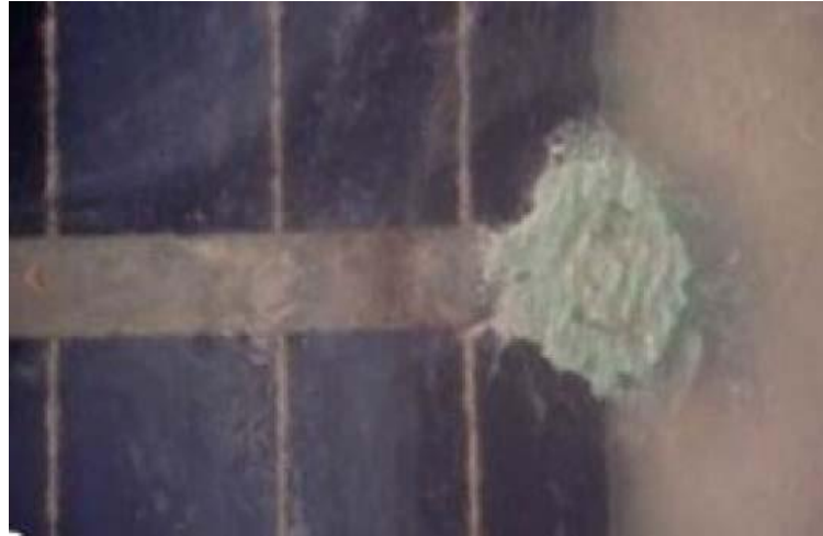
Σχήμα 1.21 Διάβρωση σε επαφή στο εσωτερικό του πάνελ [18]
