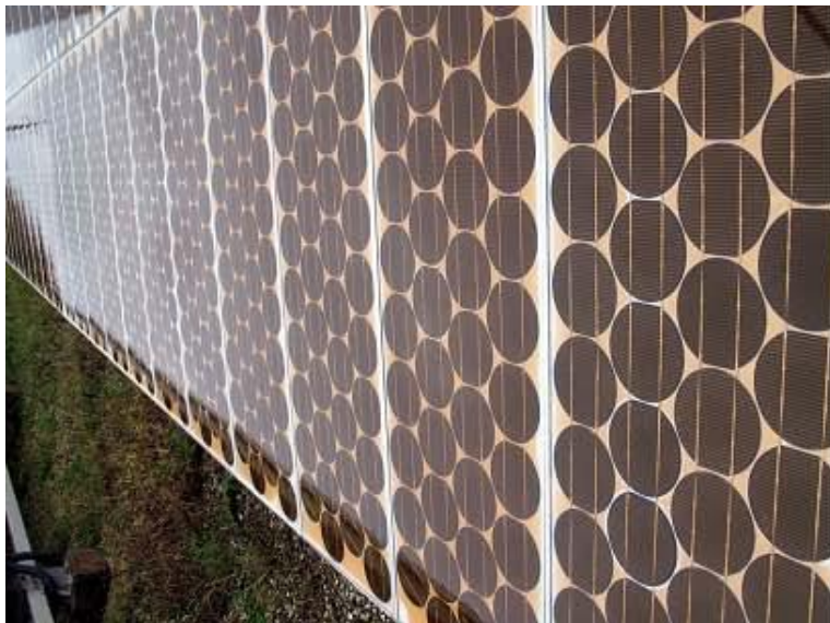
Σχήμα 1.13 Φ/Β πάνελ με εκτενή αποχρωματισμό των μεμβρανών [5]
