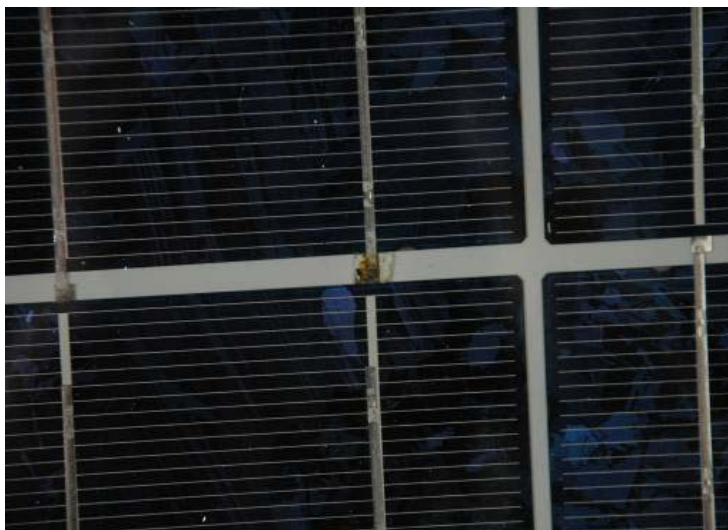
Σχήμα 3.31. Διάβρωση στις μεταλλικές διασυνδέσεις ενός πίνακα ηλιακών κυψελών [27].
